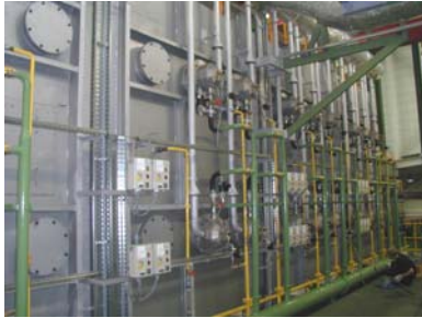
Bild 2: Verrohrung / Foto: WSP
